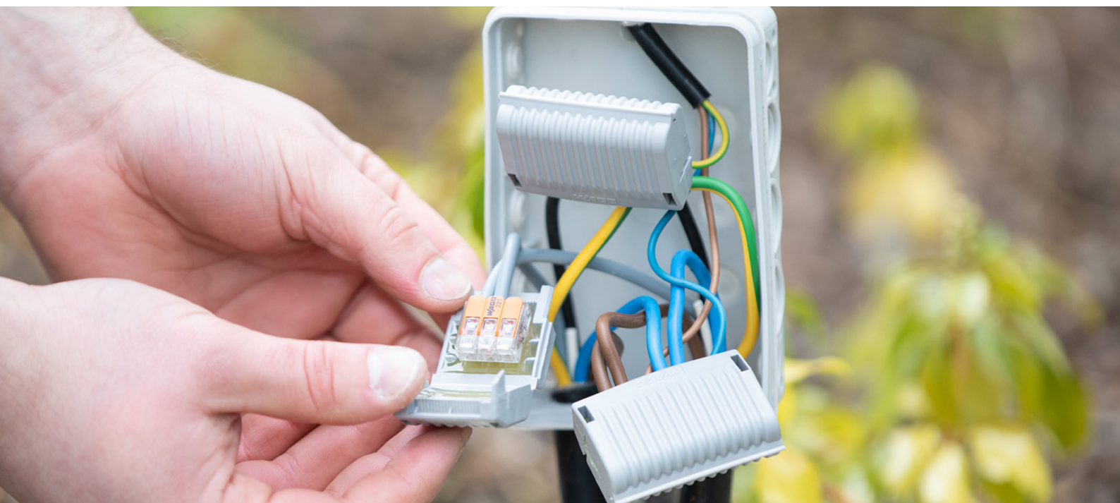
Kringen uitbreiden: Open de gelbox, verwijder de gel uit de terminal, open de terminal en monteer de kabel met nieuwe componenten.
