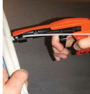
Aanspannen tot de gewenste bundeling en spanning is bekomen
